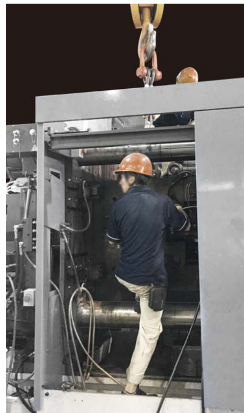
将脚放在拉杆上,然后取下模具顶部的吊钩
